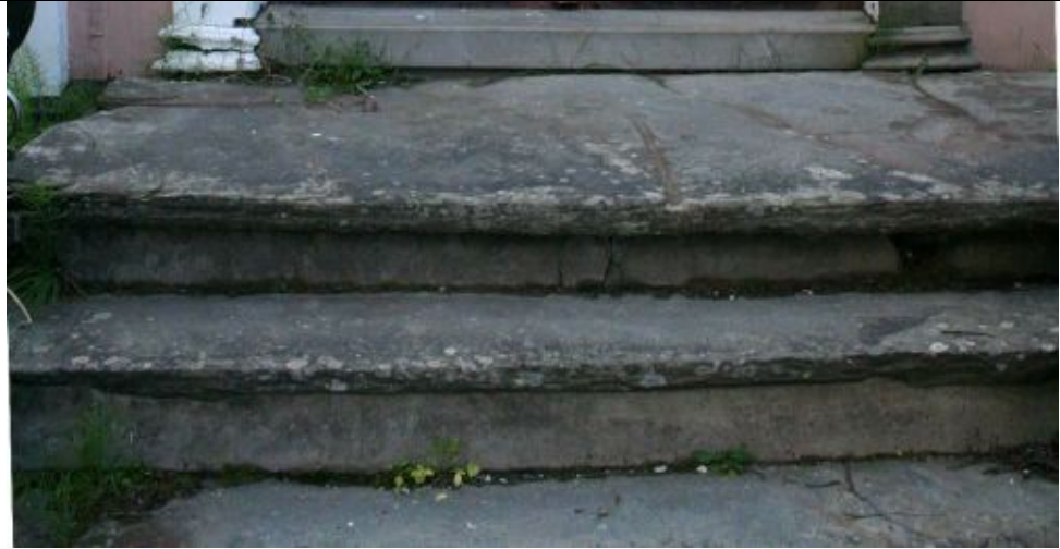
Nedre del av trappa, fra 2. trinn og opp.
