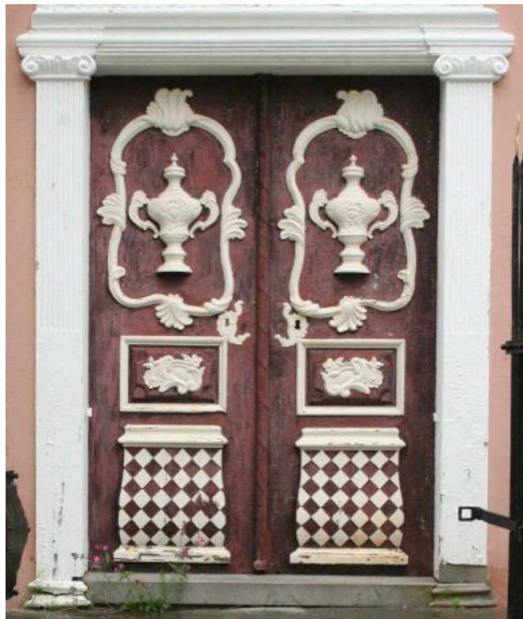
Døren med omramming og gesims. Dekoren er skåret av den kjente svenske treskjæreren Jöns Andersson Ljungberg, (1732-1818) fra Härjedalen.
