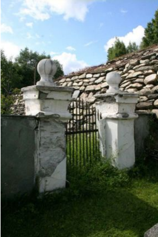
Vestporten i nordmuren til sideparken.
