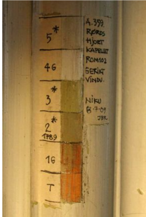
Stratigrafisk fargelagsavdekking, vindusgerikt.
