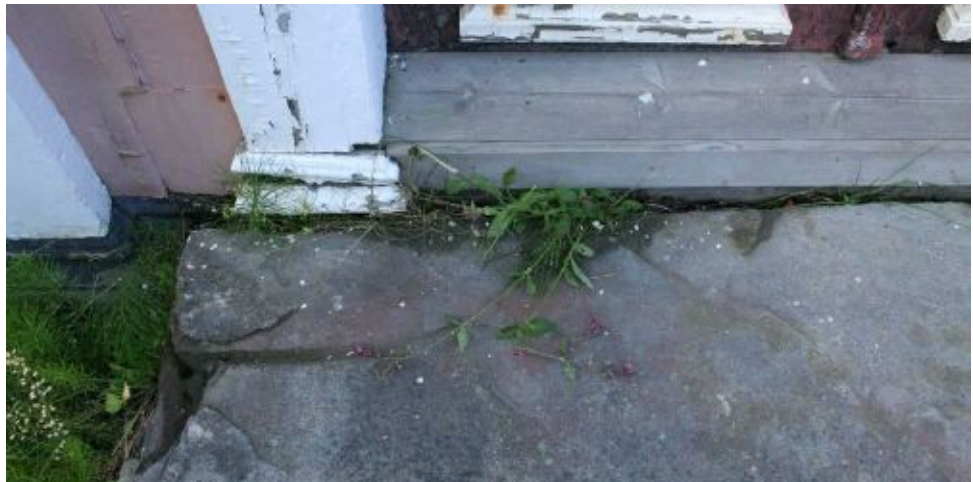
Detalj av plasseringen av øverste trappehelle ved østre dørpilasterbase.
