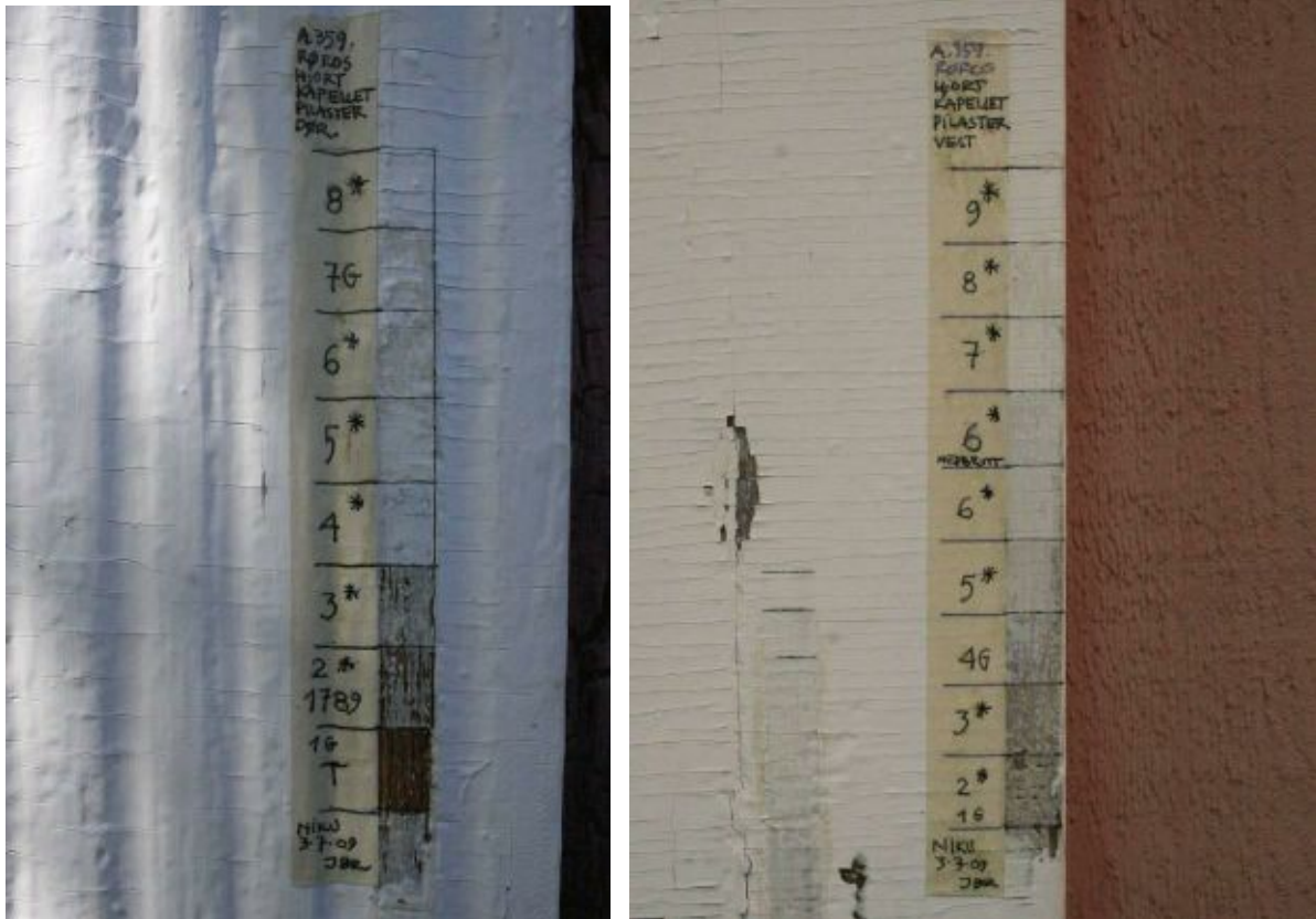
Stratigrafiske fargelagsavdekkinger på dørpilaster og pilaster på vestveggen.
