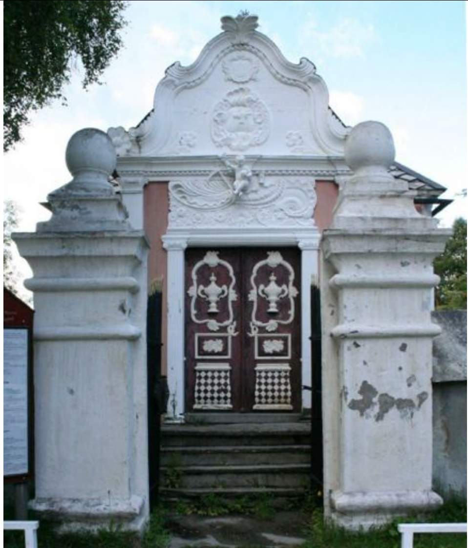
Nordveggen med inngangsporten i muren åpen. Døren, den utskårede supraporten og det utskårete gavfeltet er godt synlige.
