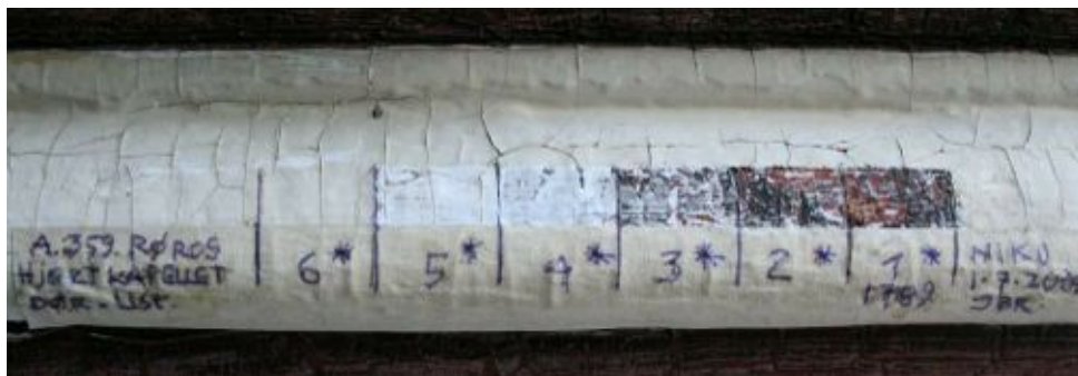
Stratigrafiske fargelagsavdekkinger på listverket på dørene.
