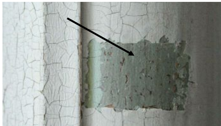
Avdekking av eldste fargelag på vinduet.
