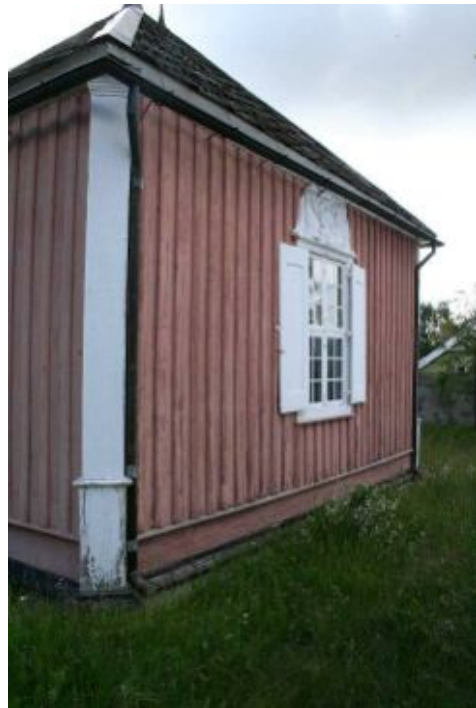
Sydveggen sett fra sydvest.
