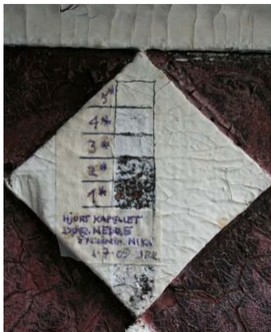
Stratigrafiske fargelagsavdekkinger på en av dekkvadratene på døren
