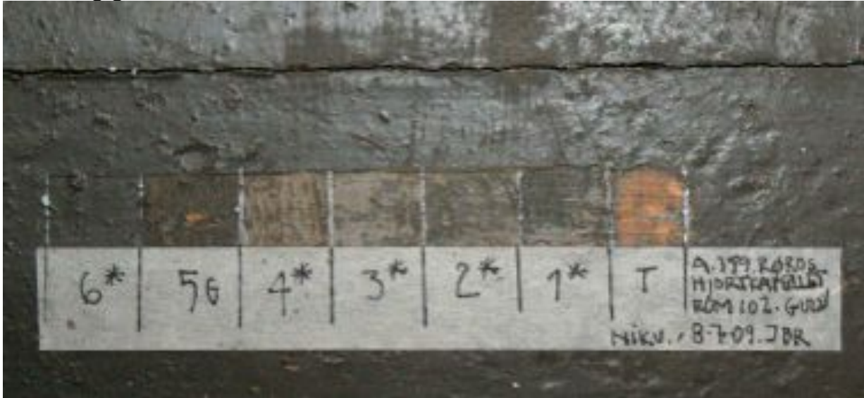
Stratigrafisk fargelagsavdekking, gulvet.
