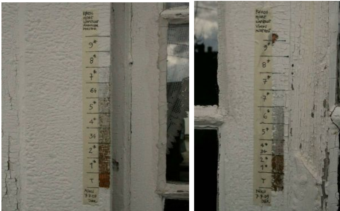
Stratigrafiske fargelagsavdekkinger på vinduslemmene og vinduets midtpost.
