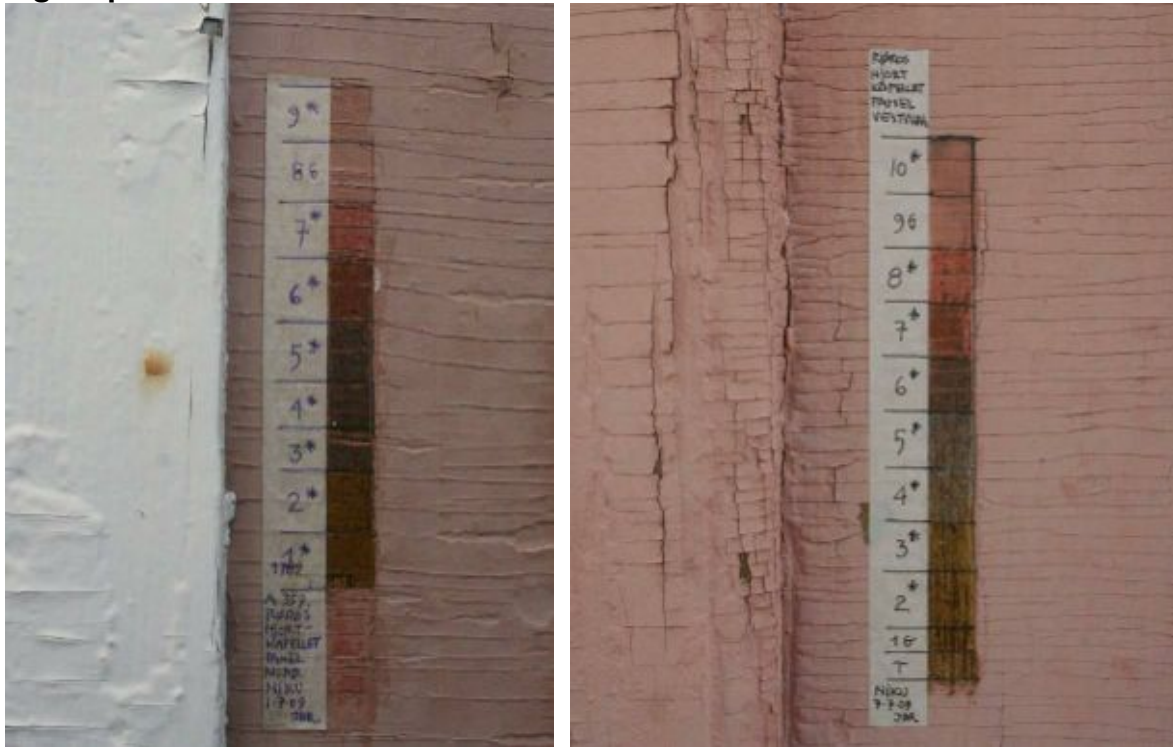
Stratigrafiske fargelagsavdekkinger på panelet på nord- og vestveggene.
