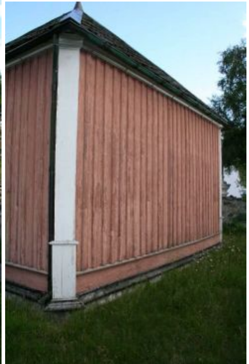
Østveggen sett fra sydøst
